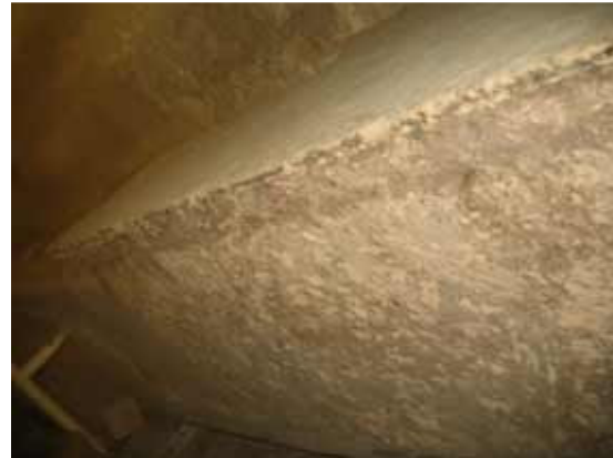
Traces brunâtres sur les banquettes Tracce brunastre sulle panchine
