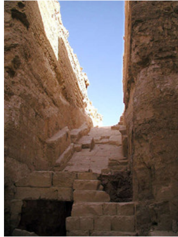
Tranchée de la pyramide d'Abou Roash
