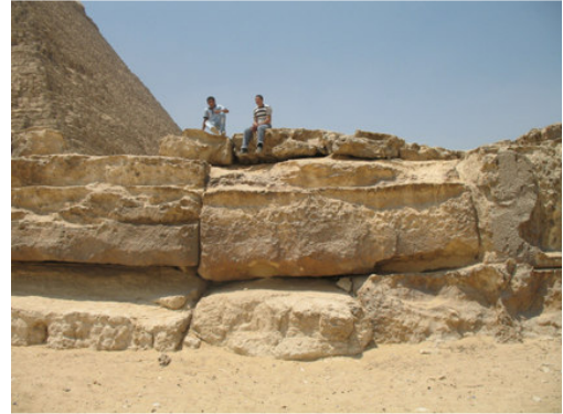
des blocs ont même été posés en délit (à droite) indiquant le côté temporaire de leur utilisation. Les personnages sur la photo donnent l'échelle
