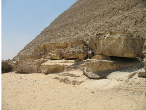
2 à 3 couches de blocs de grandes dimensions constituent la plateforme actuelle.
