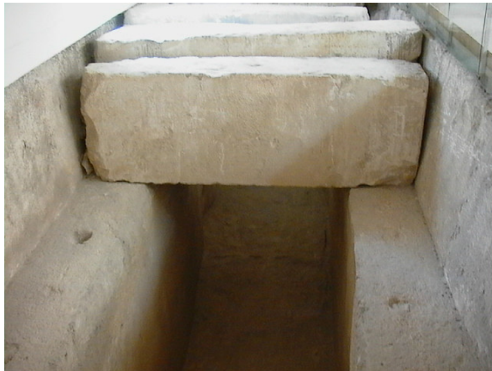
Mode de couverture de Grande Galerie différent des encorbellements habituels indiquant une mise en place ultérieure à la construction de la pièce (ici couverture du puits de la Barque Solaire).
